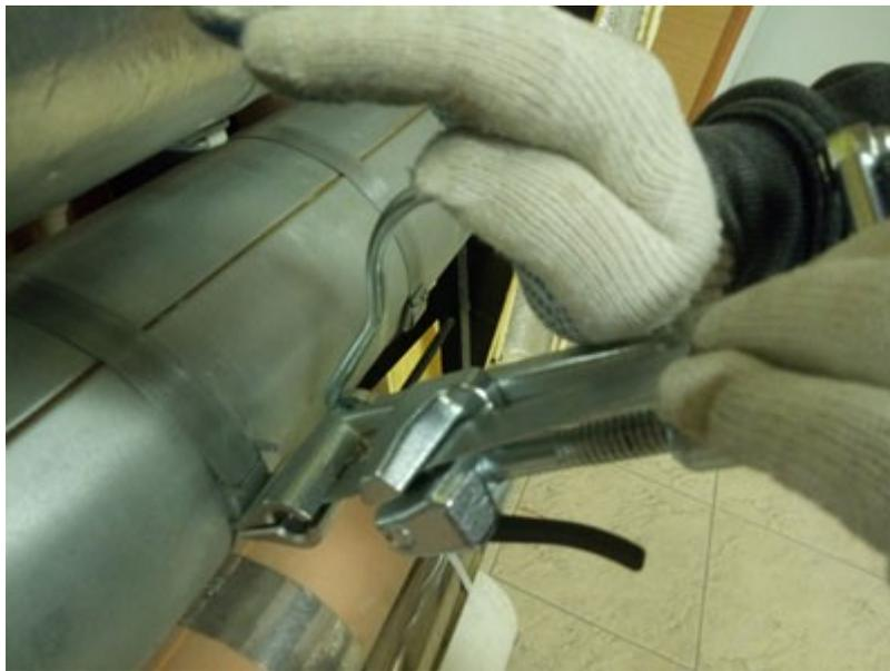
Далее поднять натяжитель вверх фиксируя натяжку на ленте и толкая от себя рычаг секатора, который расположен в передней части натяжителя удалить излишки ленты
