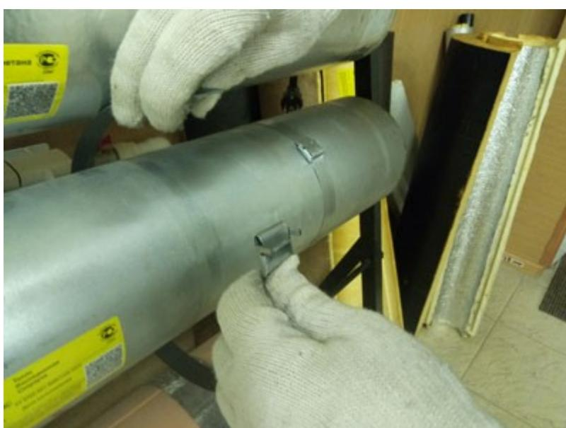
Завести подготовленную ленту на размещенную на теле трубы теплоизоляцию ППУ ТИС
