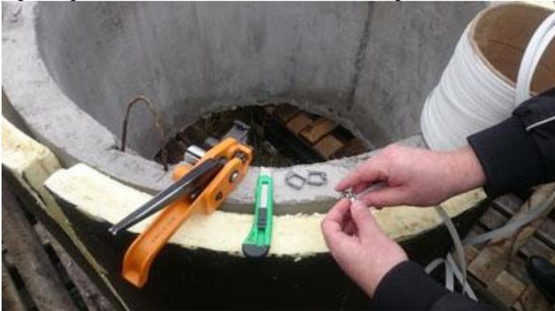
Полипропиленовой лентой теплоизоляция охватывается по наружной ее части
