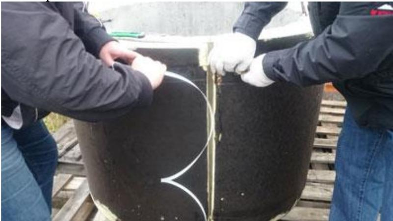
Затем устанавливается пряжка и предварительно через пряжку полипропиленовая лента вручную затягивается
