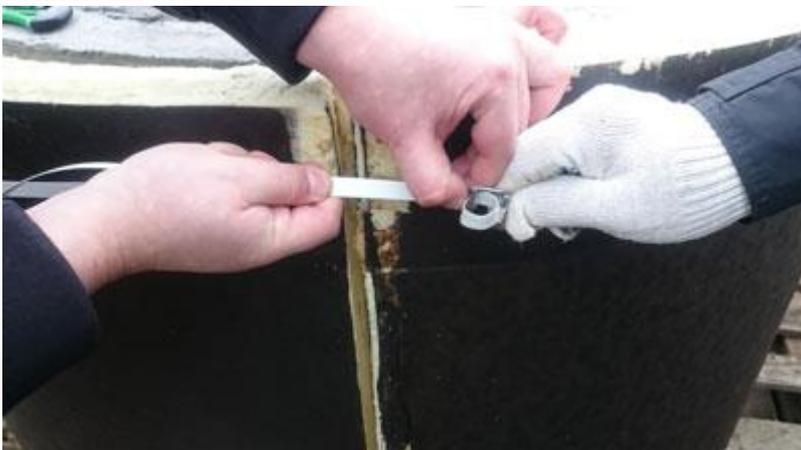
Далее при помощи натяжительной машины происходит финишная натяжка ленты вокруг теплоизоляции
