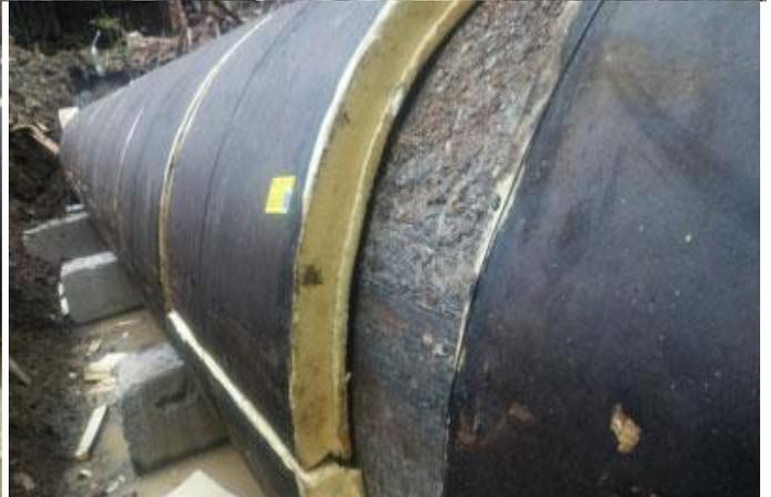
Комплект Теплоизоляции для утепления бетонных колодцев состоит их четырех сегментов плотно прилегающих к телу бетонного колодца и имеющих торцевые замки благодаря которым исключается возникновение мостиков холода
