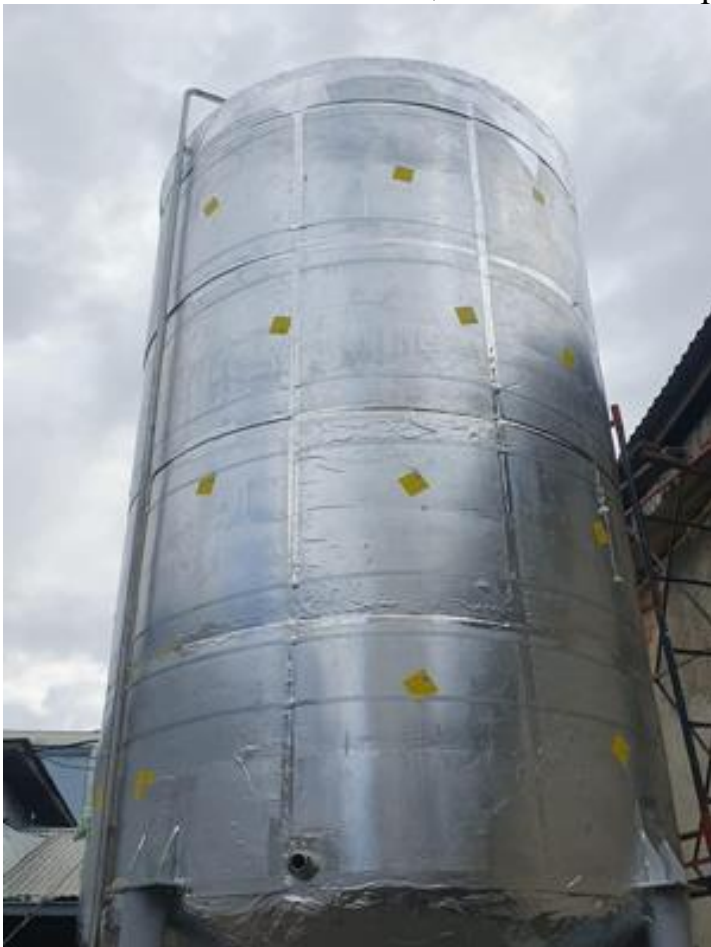
Фото: монтаж теплоизоляции на нижний торец емкости
