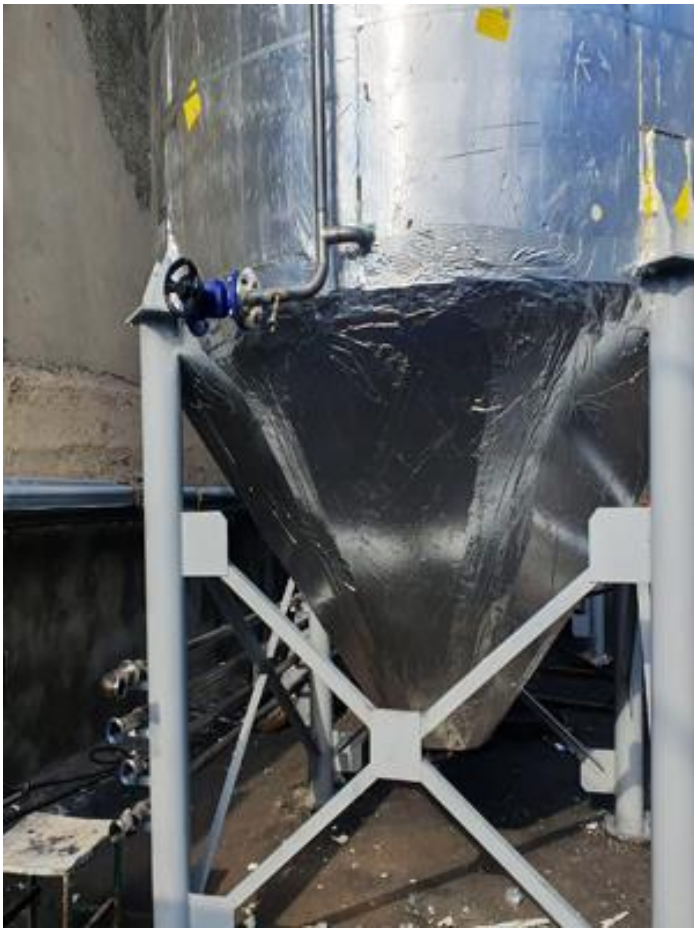
Фото: монтаж теплоизоляции на нижний торец емкости
