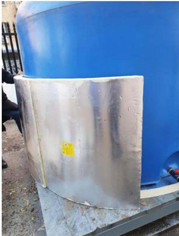
Комплекты ППУ ТИС имеют большую прочность на сжатие, поэтому они выдерживают без проблем большую нагрузку при наполнении емкости любой жидкостью. На фото показано как осуществляется монтаж боковых поверхностей емкости.
