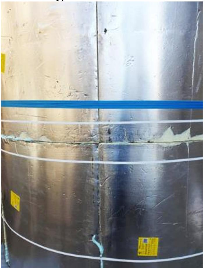
После обработки радиальных сегментов ППУ ТИС пенополиуретановым клеем, идет герметизация стыков скотчем из фольги.
