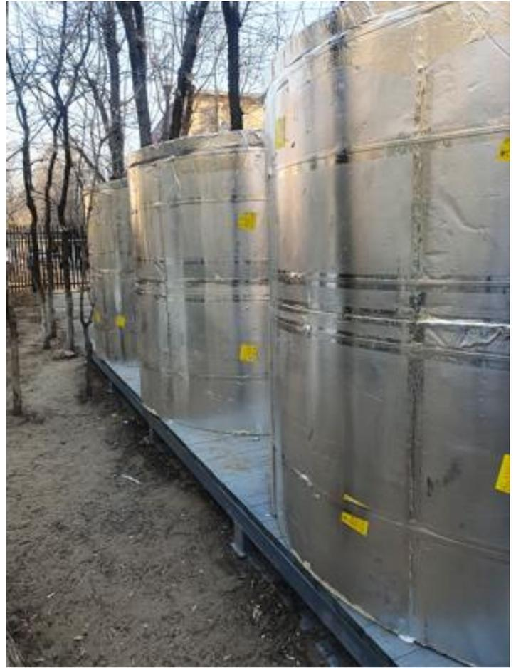
Комплект теплоизоляции ППУ ТИС для утепления емкостей любого диаметра состоит из нескольких радиальных сегментов (в зависимости от диаметра емкости) плотно прилегающих к телу емкости, и имеющие продольные замки благодаря которым исключается возникновение мостиков холода.
