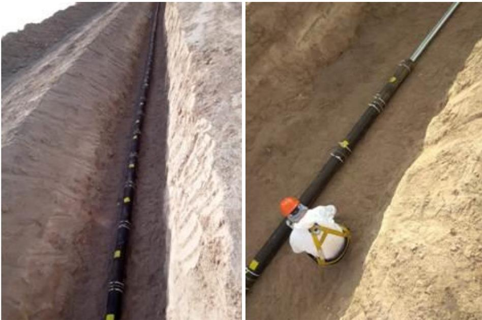
Теплоизоляция марки ТИС100 имеет большой запас по прочности на сжатие и может выдерживать очень большую нагрузку – не менее 500 тонн/м<sup>2</sup>., (не менее 0,5 МПа)
