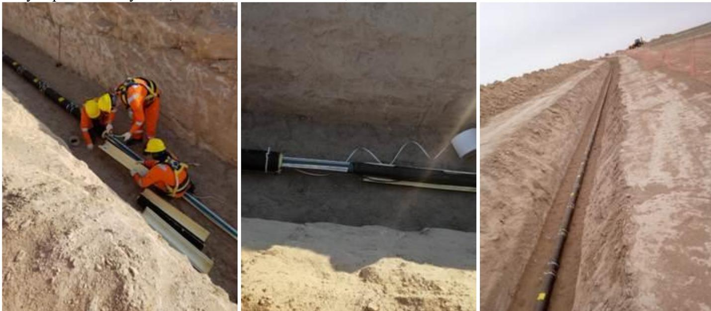
Теплоизоляция марки ТИС 100 произведена по ТУ 5768-001-86901126-2011, имеет один из самых низких коэффициентов теплопроводности среди теплоизоляционных материалов, не впитывает влагу, выдерживает большие нагрузки по прочности на сжатие и на изгиб. Плотность изделий от 71 до 100 кг/м.куб..
