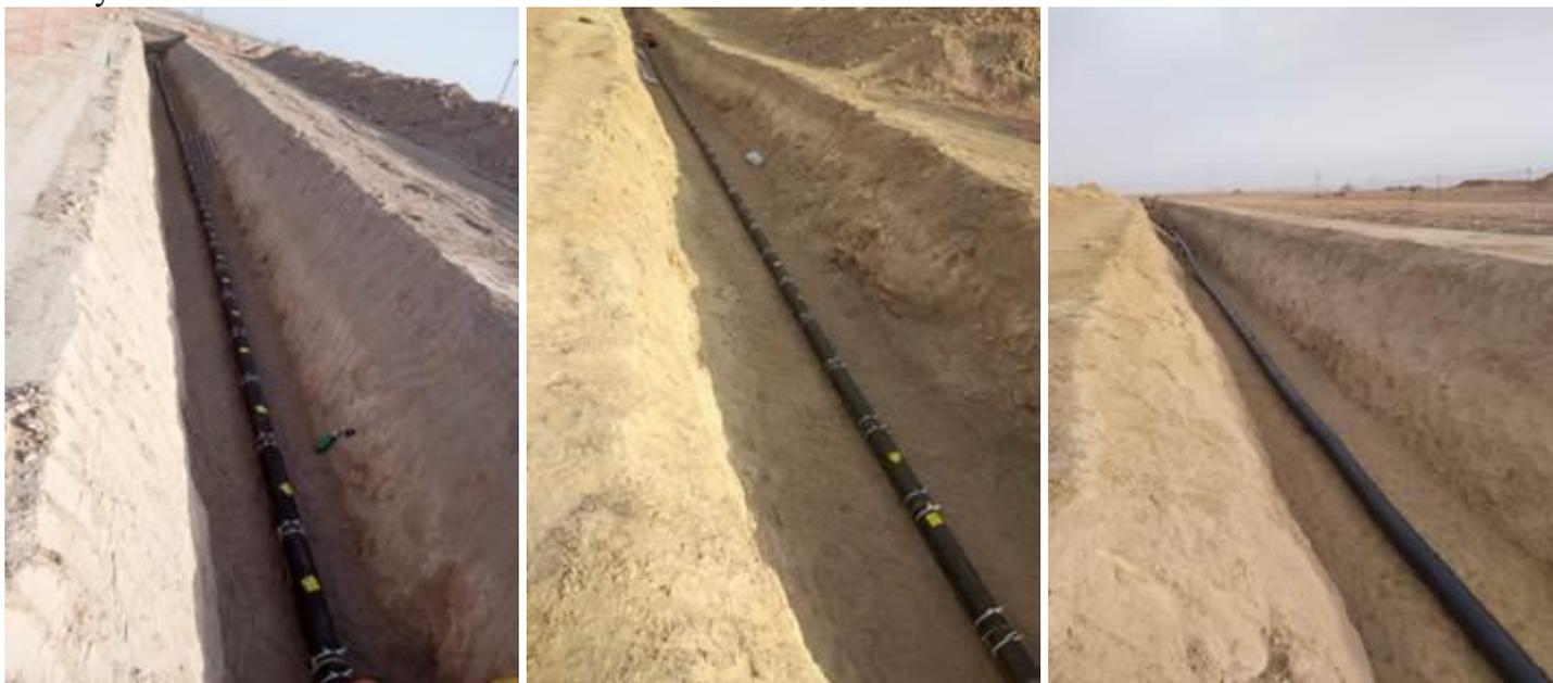
Благодаря высоким прочностным характеристикам теплоизоляции для трубопроводов марки ТИС 100, утепленные трубы можно закапывать в землю, не применяя железобетонные лотки, в которых обычно размещаются трубы с теплоизоляцией.
